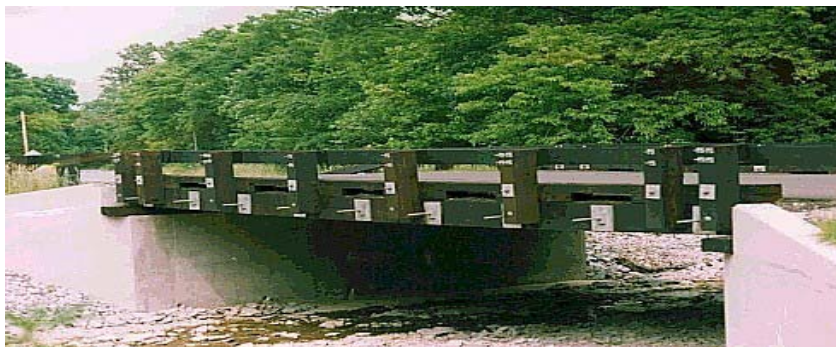
Figura 1: Puente de madera postensada transversalmente en EEUU (11m de largo).
