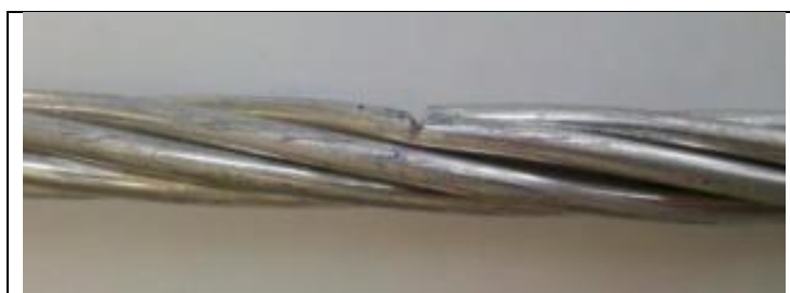
Fig. 4.12. Corte de 2.5 [mm] de profundidad en conductor ACSR.
