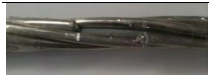
Fig. 4.13. Corte de 2 [cm] de hebra en conductor ACSR
