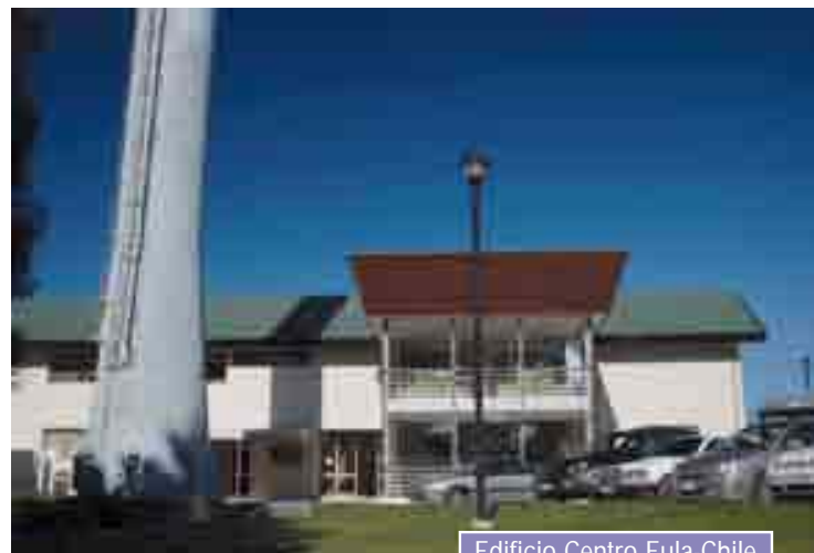
Edificio Centro Eula-Chile
