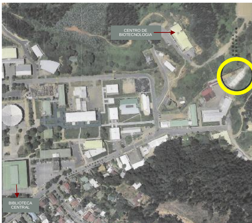
Foto N°1: Foto aérea del emplazamiento del Centro de Acopio Temporal de Residuos
