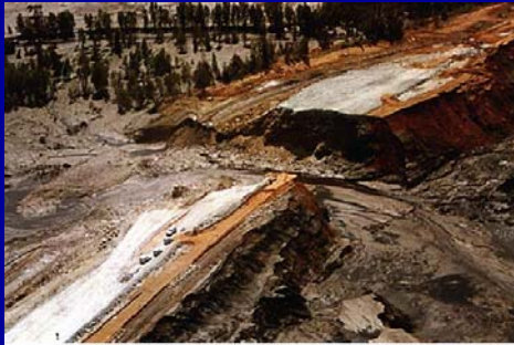
1 Rotura de la presa de la balsa que contenía los residuos tóxicos en la mina de Aznalcóllar, el día del vertido.
