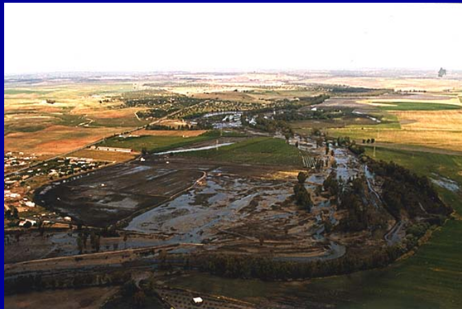
Vertido tóxico en el río Agrio en las inmediaciones de la presa, en el día de la ruptura.
