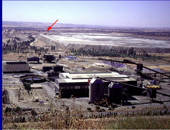
En primer plano, instalaciones mineras. Al fondo la balsa de contención de estériles. La flecha indica el lugar por donde se produce la rotura
